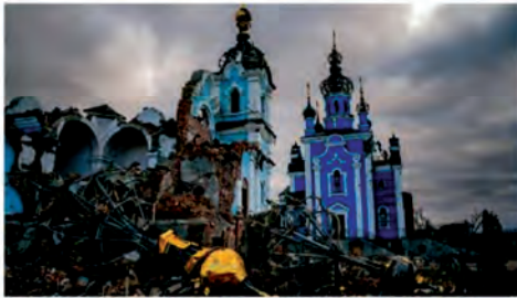
Das bei russischen Angriffen schwer beschädigte Dorf Bohorodychne in der Region Donezk.
